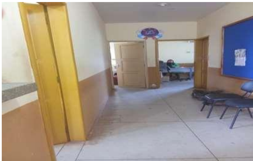
Figura 07 Sala da coordenação pedagógica do colégio MAC
