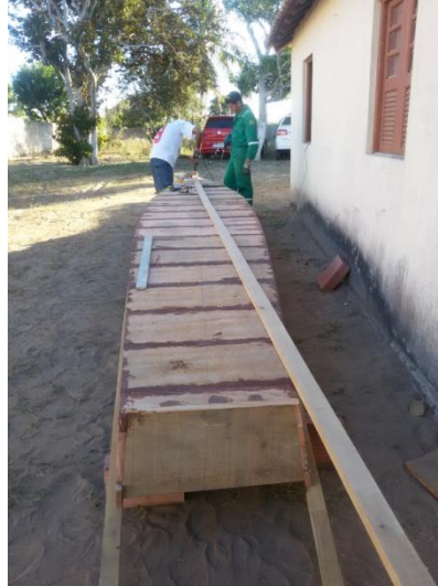
Figura 102- Sobrequilha sendo colocada Fonte: Grazieli, 2016
