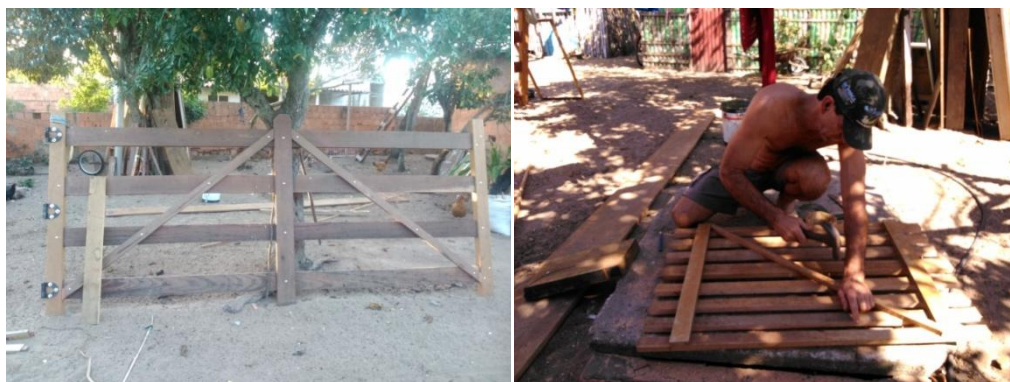
Figuras 79 e 80—A primeira foto mostra a cancela feita por Tião. A segunda mostra Tião construindo um pequeno portão.
